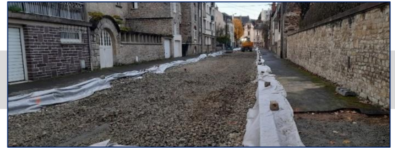
▲ Chaussée à structure réservoir en construction sur Rennes
