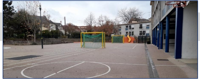
▲ Cours d'école à Rennes en enrobée sur structure d'infiltration
