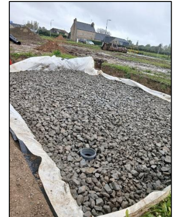
▲ Cours d'école à Rennes en enrobée sur structure d'infiltration
