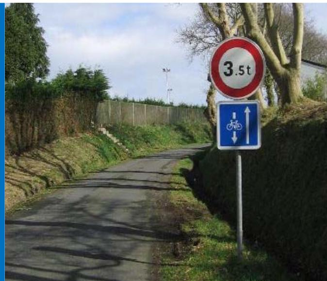
La bande cyclable le long des routes doit avoir une largeur d'au moins 1,70 mètre pour réellement sécuriser le cycliste. Elle est ici insuffisante.
