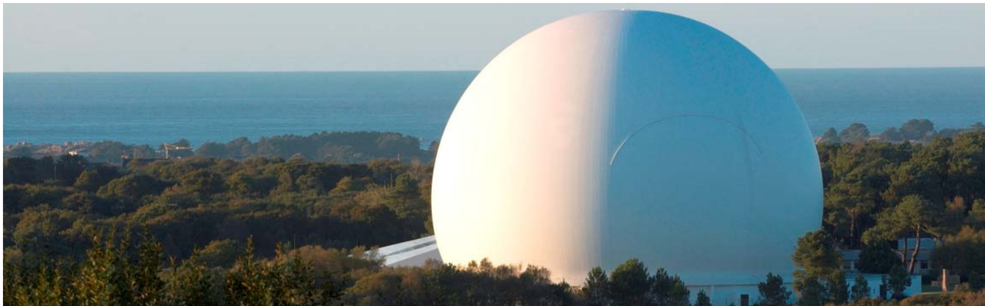
Exemple 2. Le Radôme est l'un des éléments construits les plus emblématiques du Trégor, par ailleurs installé dans un site naturel exceptionnel
