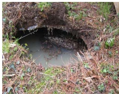
Cette installation s'est dégradée en moins de douze ans, faute d'entretien. L'hydrogène sulfuré de la fosse a rongé le béton au point que la dalle de couverture s'est brisée.
