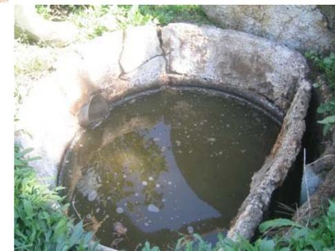
Le contrôle montre qu'elle est gorgée d'eau et donc qu'elle ne permet plus l'assainissement normal des effluents.
