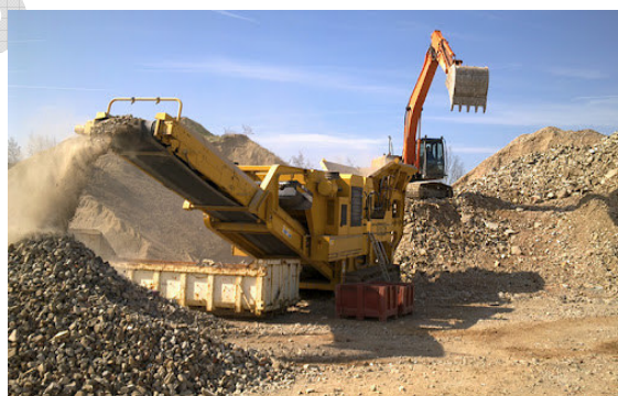
Figure 31 : Concassage des déblais et gravats en vue de leur valorisation
