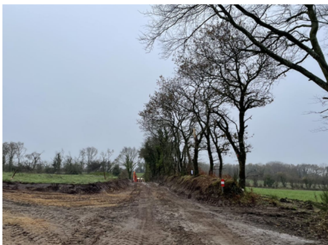
Chemins d'accès décapés
