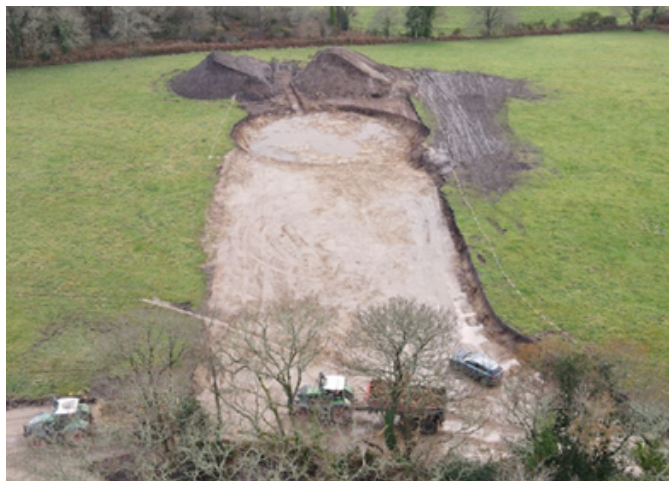
Décapage et terrassement d'une plateforme d'éolienne
