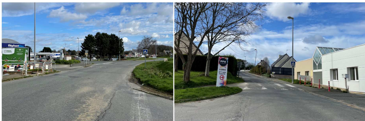
Tronçon sud de la rue de Kerliviec
