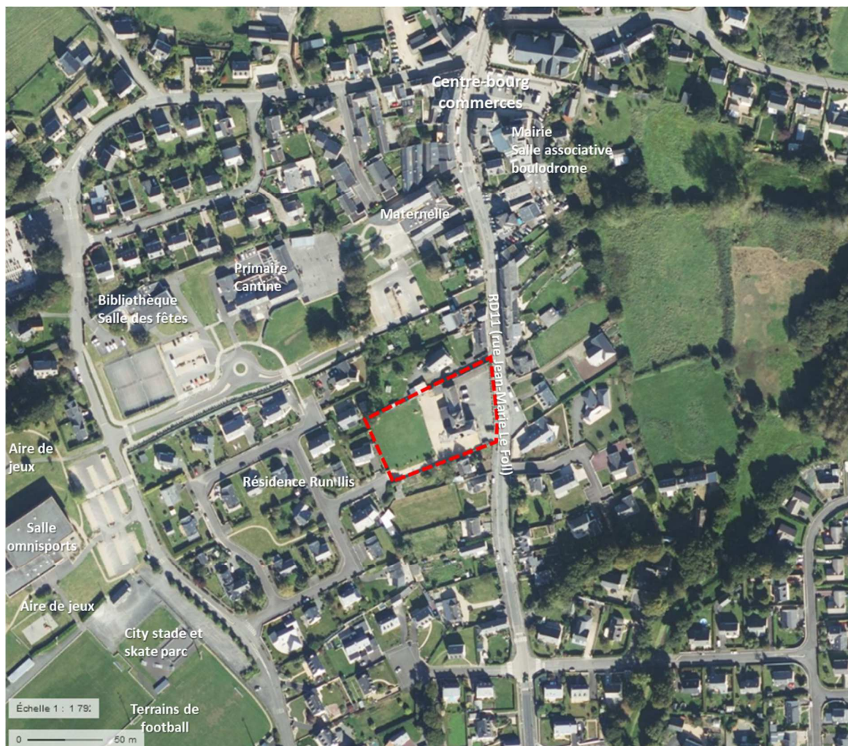
Environnement du site de Saint-Louis
