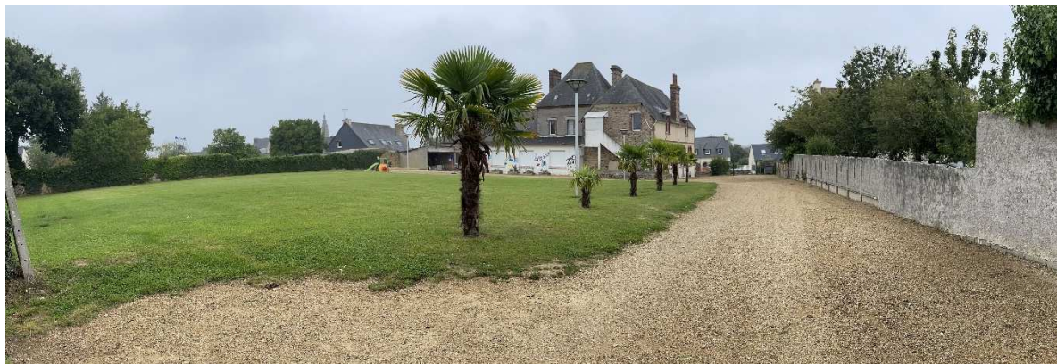
Vue du site depuis son accès Run Iliz
