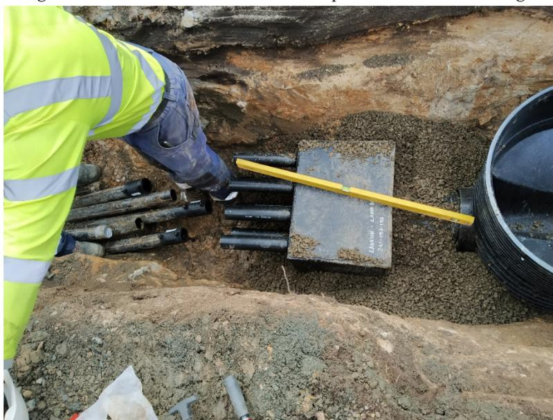
Figure 53 : Pièce spécifique pour le raccordement des 6 habitations de Crech Ar C'Higer
