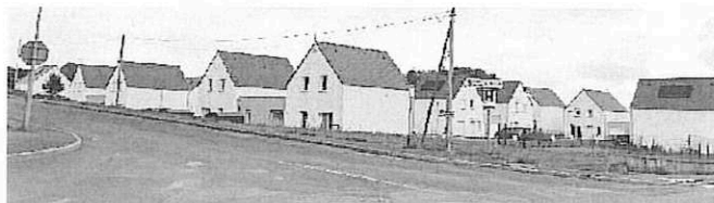
Opération de 26 logements locatifs sociaux réalisés récemment près du collège
