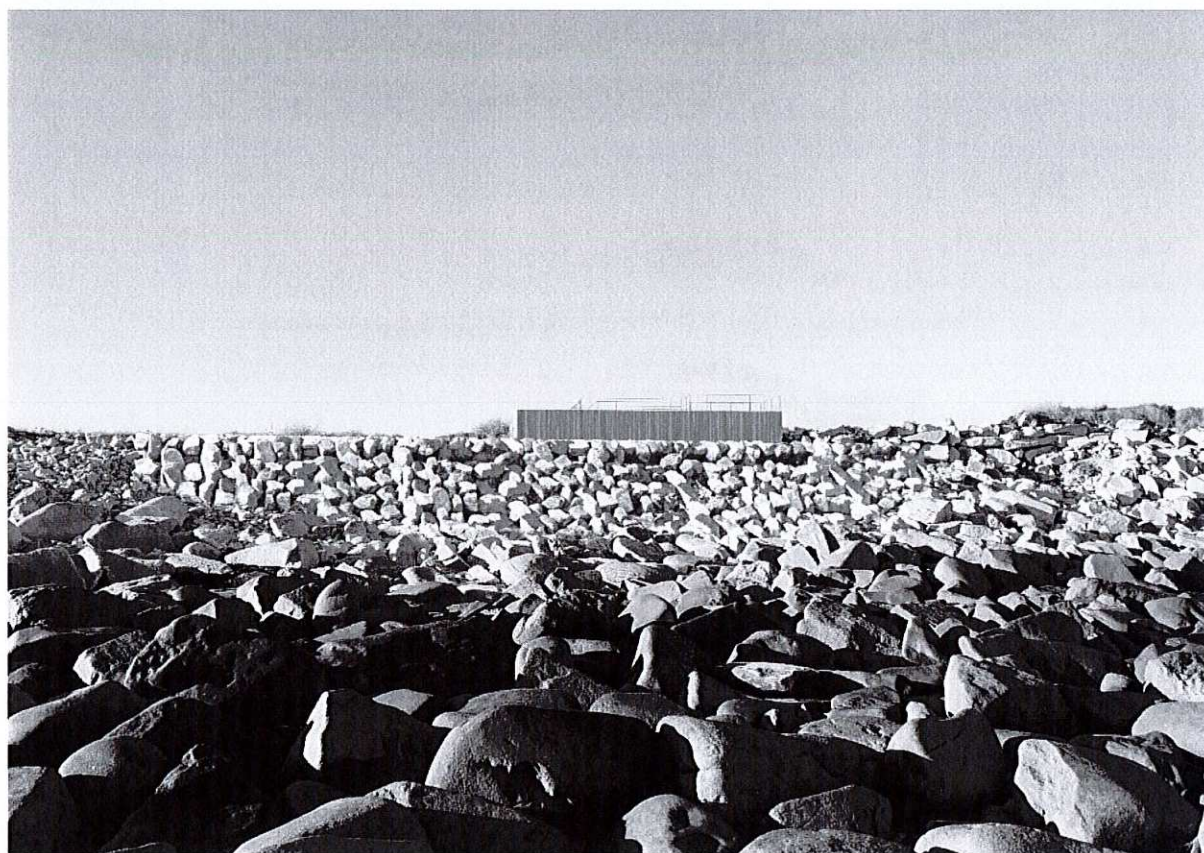
Vue rapprochée du futur ouvrage et de l'enrochement, réalisée au niveau du rivage (depuis le Nord)
