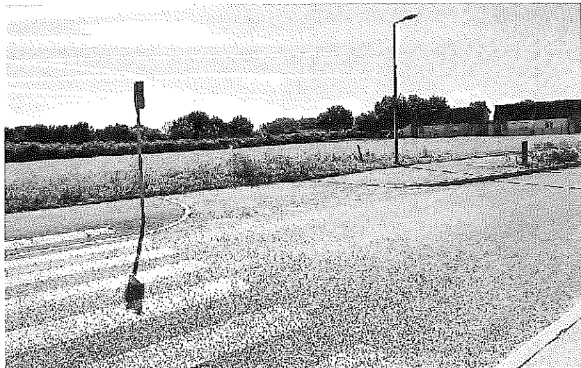
Accès aménagé rue du Générale de Gaulle
