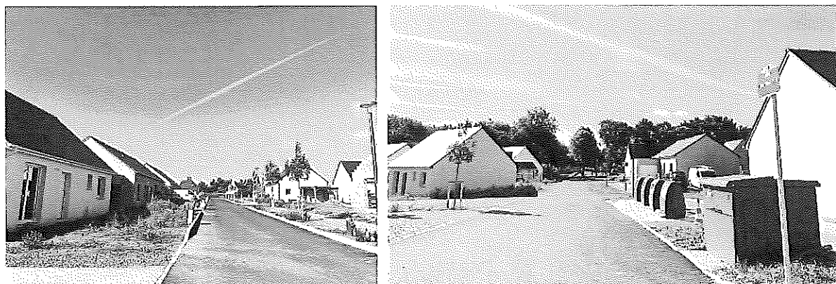
Lotissement de Kerhuellan au sud du site
