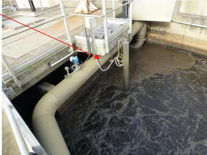
Le niveau sonore est de 83 dB(A) au droit de la canalisation. Il s'agit de la source la plus prépondérante de la STEP.
