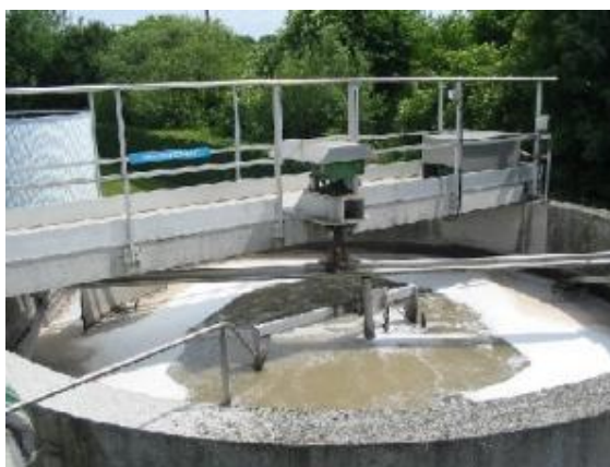
Exemple d'un dégraisseur-dessableur
