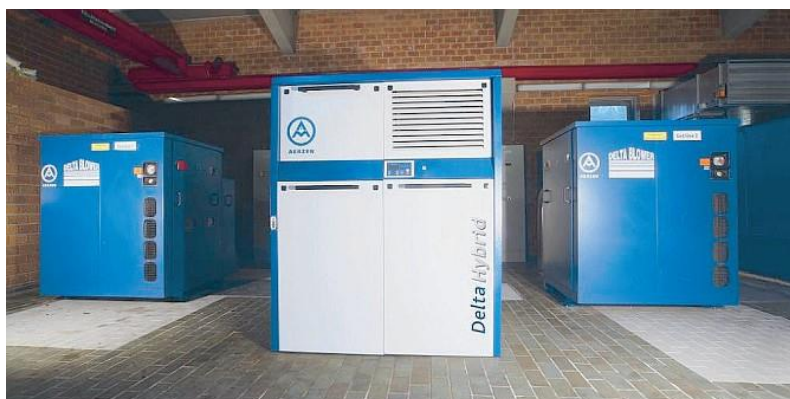
Exemple de compresseurs d'air dans un local insonorisé
