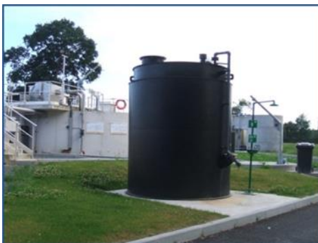
Exemple d'une cuve de chlorure ferrique
