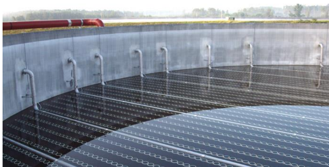
Exemple de bassin avec plancher d'insufflation
