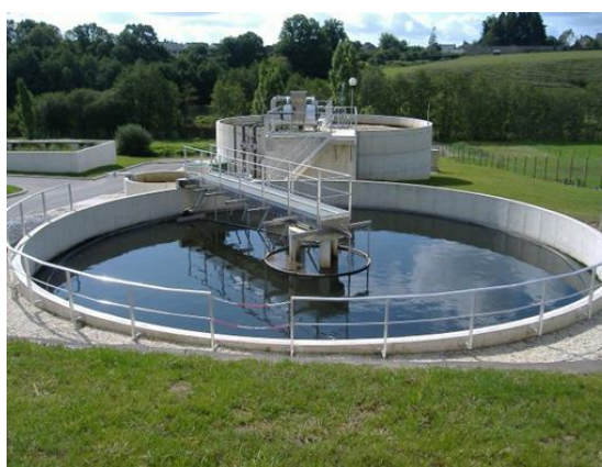
Exemple de clarificateur
