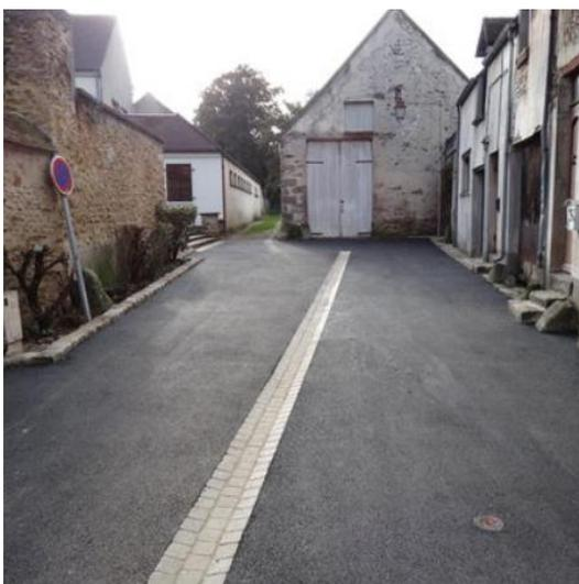
Quelques exemples de dispositifs de gestion des eaux pluviales : fossé en bordure de voie, noue paysagère, voie avec un profil en « V » permettant de canaliser les eaux pluviales
