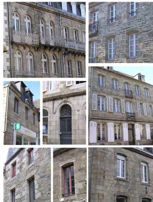
L'ensemble de la façade est en pierre de taille, ou en pierre de qualité suffisante pour rester visible. Il n'existe pas ou peu de retrait entre les encadrements et le reste des murs. Alors, le rejointoiement est adapté.
