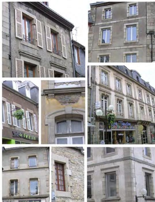
L'ensemble des éléments d'encadrements, bandeaux, chaînages est clairement créé pour rester apparent. L'enduit met alors en valeur ces pierres taillées, illumine et structure la façade.
