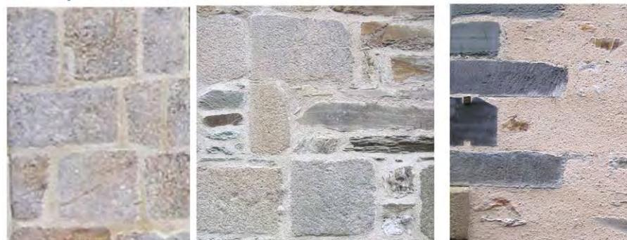
La précision de la taille des pierres et le retrait entre les encadrements, chaînages...et les murs pleins définit l'épaisseur du joint.
