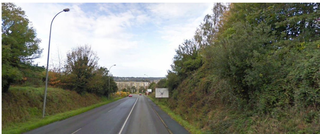
Vue actuelle du Boulevard Louis Guilloux
