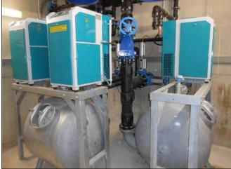
Figure 78 - Cuves de transit et surpresseurs (source : uft.fr)
