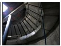
Figure 87 - Cône de décantation inox d'un décanteur digesteur
