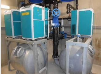
Figure 105 - Cuves de transit et surpresseurs (source : uft.fr)
