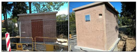
Figure 80 - Exemple de local surpresseur béton imitation bois (Source : NTE)
