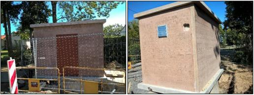
Figure 107 - Exemple de local surpresseur béton imitation bois (Source : NTE)
