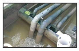
Si la déclivité des lieux le permet, les filtres plantés de roseaux peuvent être alimentés entièrement de façon gravitaire à l'aide de siphons auto-amorçant adaptés tant à la nature des eaux usées qu'au débit nécessaire pour obtenir une bonne répartition des eaux et des matières en suspension en surface des filtres du premier étage.
