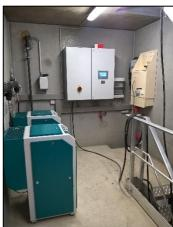
Figure 81 - Exemple d'aménagement de local surpresseur et process (Source : NTE)
