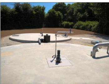
Figure 86 - Vues de Décanteurs Digesteurs enterrés avec dalle de couverture
