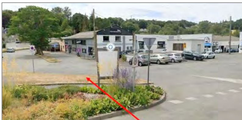
Photographie de l'emplacement du futur regard de trop-plein (source : cahier des charges)
