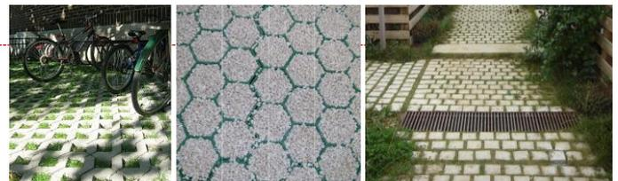
Exemple de matériaux perméables : dalle béton enherbée, gravillons, pavés non jointoyés
