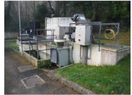
Photo 4 : Prétraitement (dégrillage, dessablage et dégraissage)
