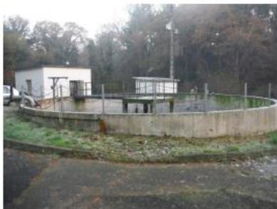
Photo 11 : Silo de stockage à boues de 300 m<sup>3</sup>
