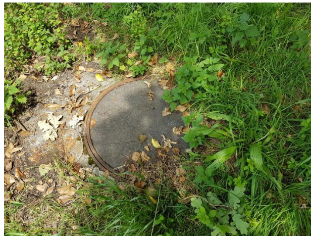
Regard amont canal - arrivée
