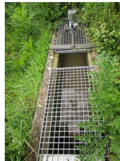
Canal de comptage en entrée
