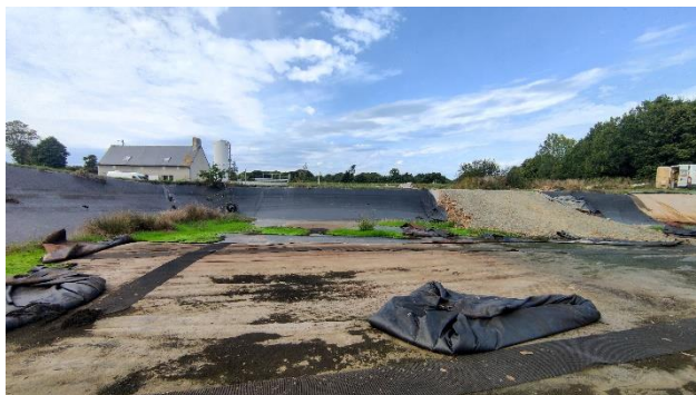
Figure 3 Vue du Bassin N°1 asséché - Septembre 2022
