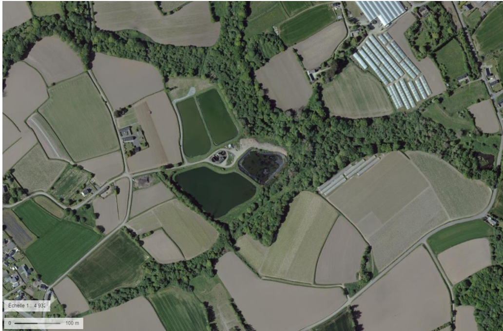
Figure 75 : Photo aérienne du site en 2022 (IGN)
