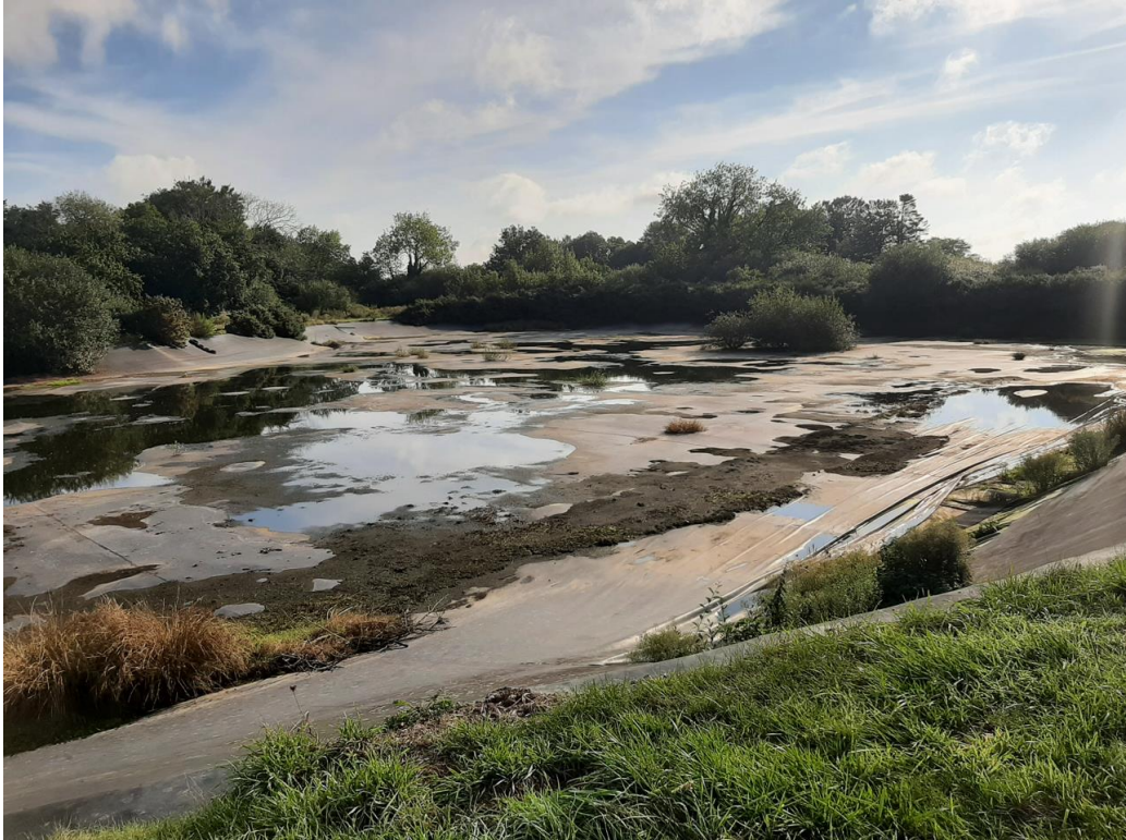
Figure 51 : Photo de la lagune à l'arrêt
