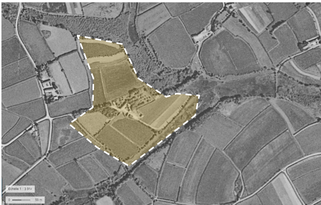
Figure 78 : Photo aérienne du site en 1952 (IGN)
