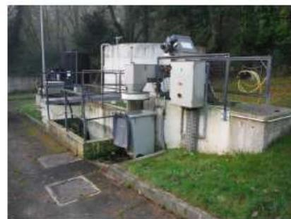
Photo 4 : Prétraitement (dégrillage, dessablage et dégraisage)
