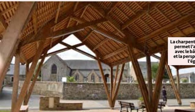
La charpente en ciseaux, permet l'alignement avec le bâti alentour et la perspective avec l'église.
