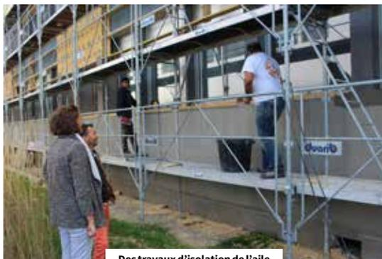
Des travaux d'isolation de l'aile plus ancienne du siège de l'Agglo augmenteront ses performances thermiques.
