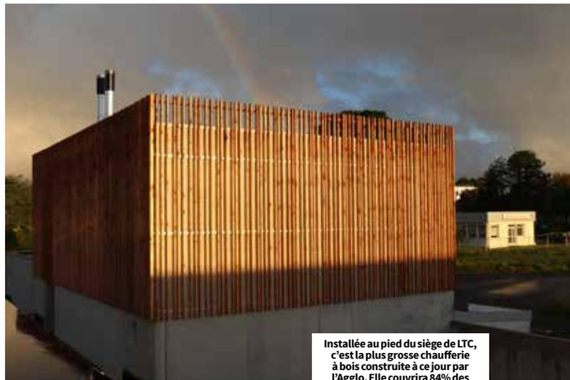
**Installée au pied du siège de LTC, c'est la plus grosse chaufferie à bois construite à ce jour par l'Agglo. Elle couvrira 84% des besoins des bâtiments desservis, le complément étant assuré par une chaudière à gaz.**
