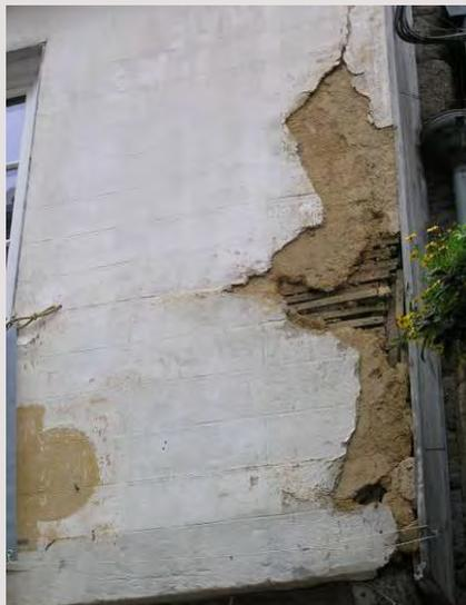
Détail d'un enduit terre et fibre sur un lattis de bois fixé à la structure. La couche de finition à la chaux recrée un semblant de joints de pierre (joints en creux), décor plus urbain.
