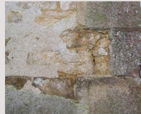
À Plufur : plusieurs strates de l'enduit ; on voit le mortier de maçonnerie des petits moellons en terre et chaux et une couche fine chaux-ciment et la finition projetée.
