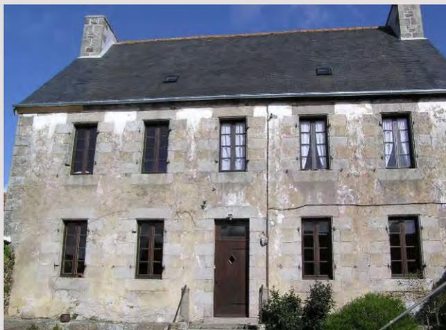
Pleumeur-Bodou : façade enduite en surface très homogène, sans retrait ni surépaisseur. Trace d'un badigeon en façade.
