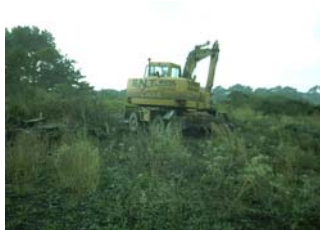
Destruction et évacuation d'anciens locaux désaffectés
