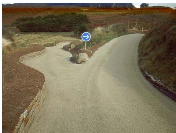
Réaménagement des aires de stationnement
