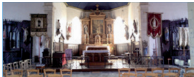
Travaux sur l'église de Buhulien à Lannion
